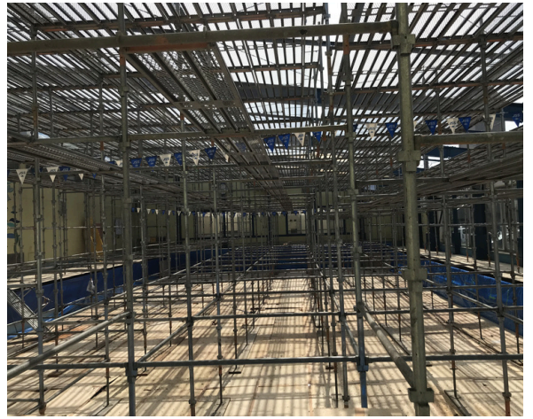
屋根がなくなり 空が見えます✨
