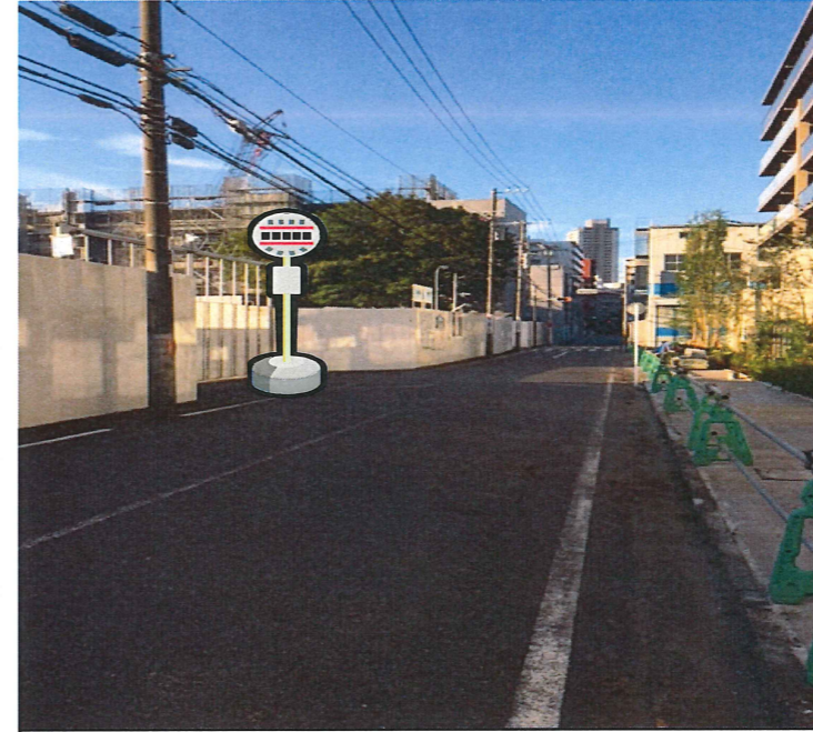
送り① オーベルグランディオ(建設中)
