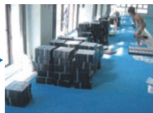
プールサイドにタイル搬入
