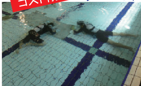
タイル補修水中施工
